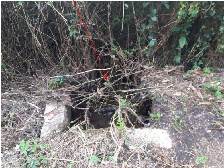
Figure 5 : Point de rejet au fossé communal
