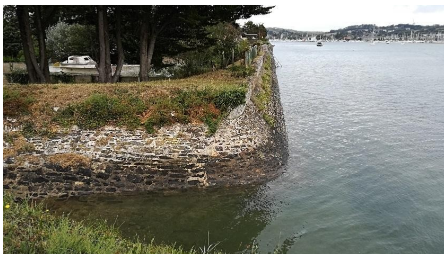
Photographie 1 : Digue Bel Abri - Beau Site, 2021
