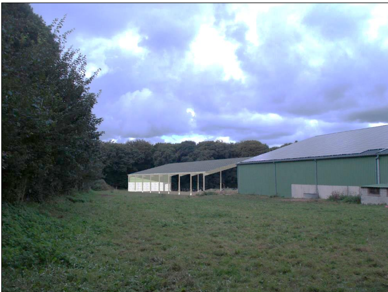
Figure 2 : Insertion paysagère du bâtiment de stockage en projet sur le site « La Ferme Neuve »
