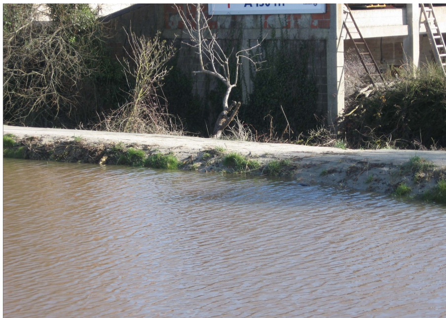
Figure 16: Niveau marin élevé en rive droite de la Taute entre le pont de la RD 974 et le pont de la Rue Giesmard, le 2 mars 2010
