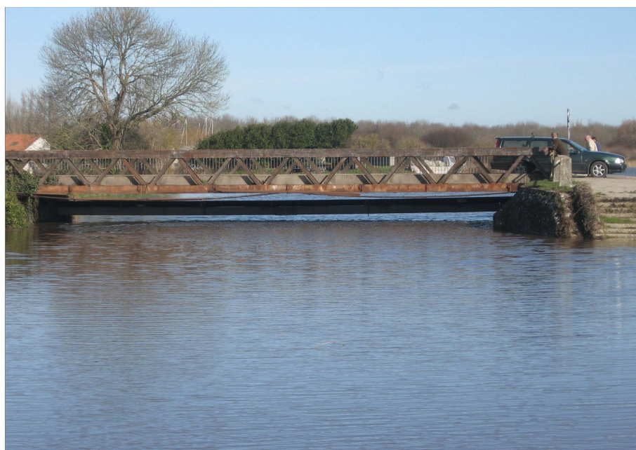
Figure 17: Niveau marin élevé au niveau du pont de la rue Giesmard, vue vers l'aval, le 2 mars 2010
