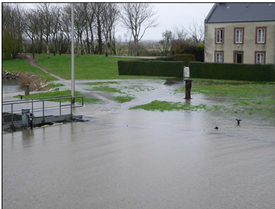
Figure 14 : Écoulement dans le port en rive gauche de l'entrée à l'écluse durant la tempête Xynthia (28 février 2010)
