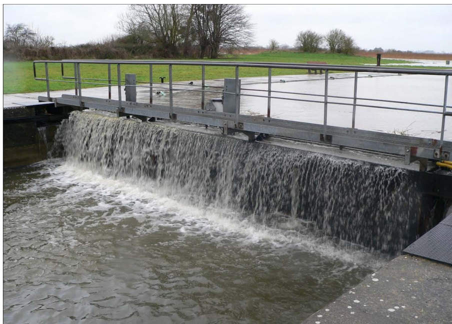
Figure 12 : Début de surverse de l'écluse du Haut Dick durant la tempête Xynthia (28 février 2010)
