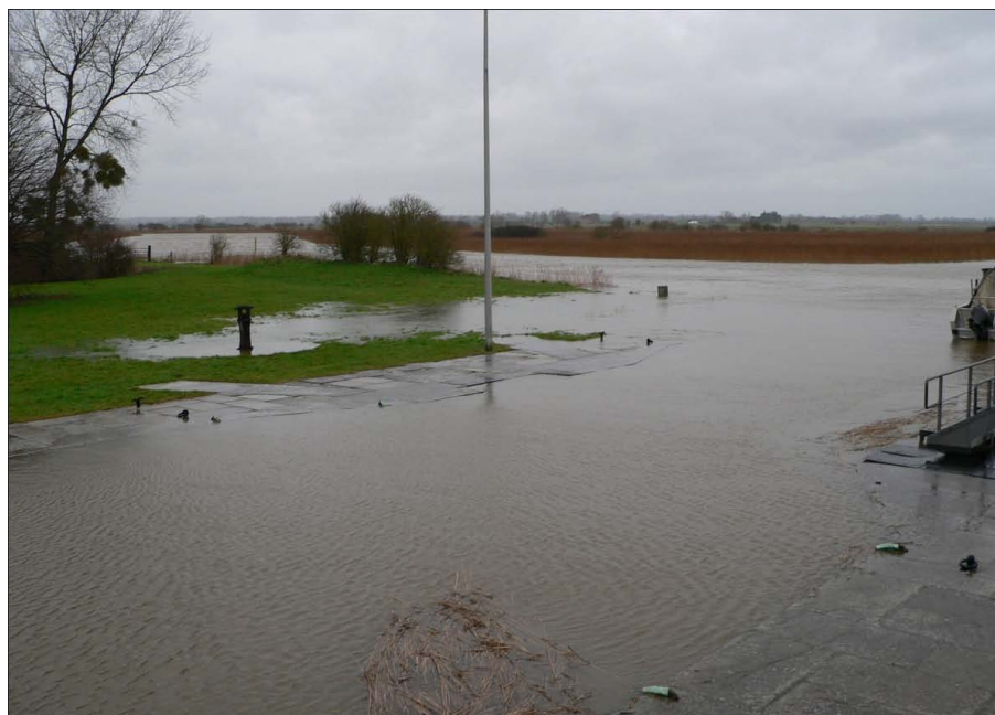
Figure 13: Débordement des digues et quais en rive gauche de l'entrée à l'écluse durant la tempête Xynthia (28 février 2010)
