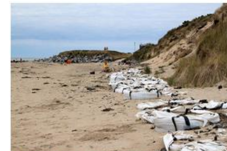
• Erosion dunaire, big bags et enrochements, plage de
