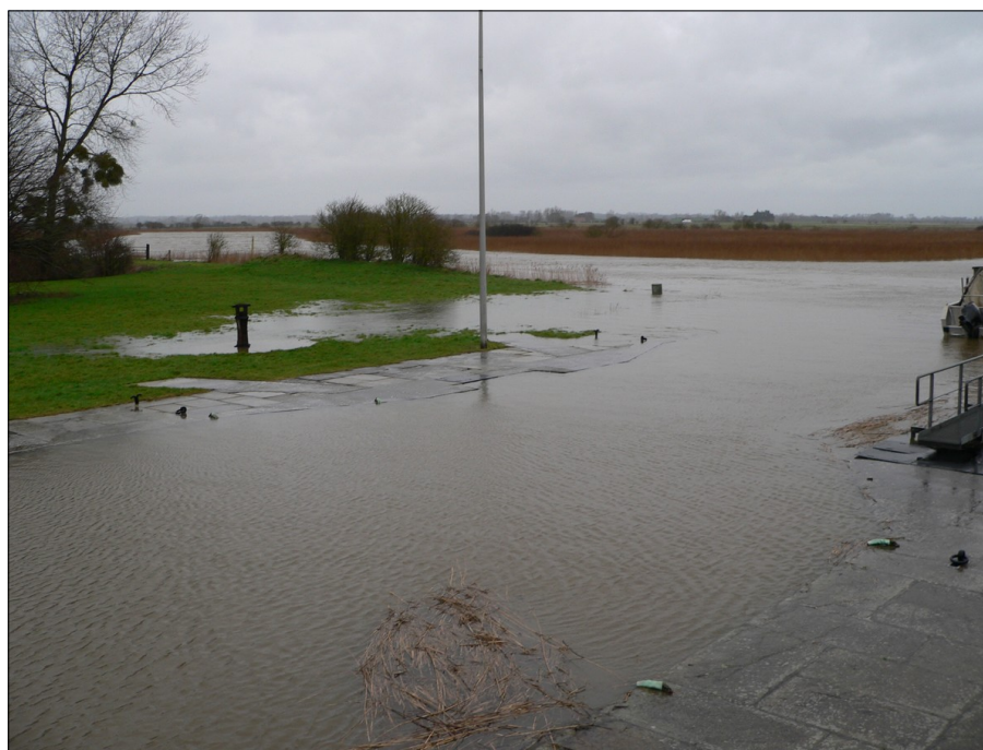
Figure 13: Débordement des digues et quais en rive gauche de l'entrée à l'écluse durant la tempête Xynthia (28 février 2010)
