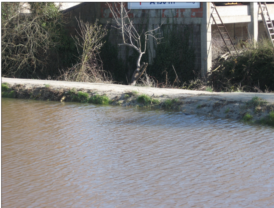
Figure 16: Niveau marin élevé en rive droite de la Taute entre le pont de la RD 974 et le pont de la Rue Giesmard, le 2 mars 2010
