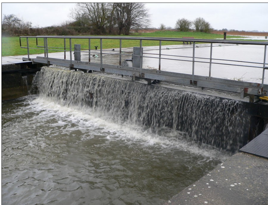
Figure 12 : Début de surverse de l'écluse du Haut Dick durant la tempête Xynthia (28 février 2010)
