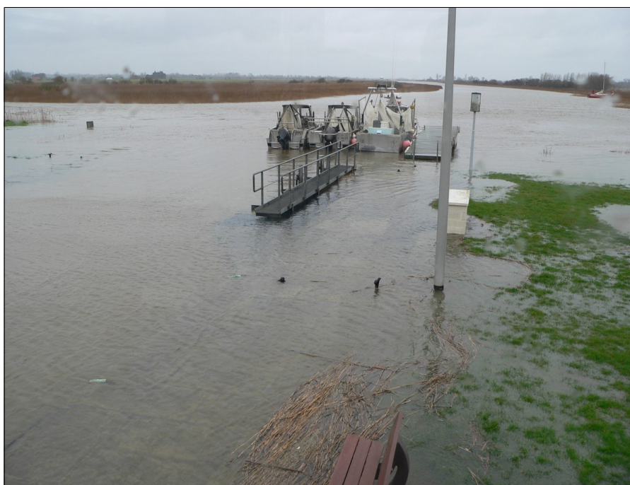
Figure 15: Débordement des digues et quais en rive droite de l'entrée à l'écluse durant la tempête Xynthia (28 février 2010)
