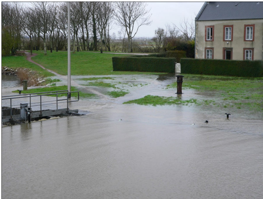
Figure 14: Écoulement dans le port en rive gauche de l'entrée à l'écluse durant la tempête Xynthia (28 février 2010)
