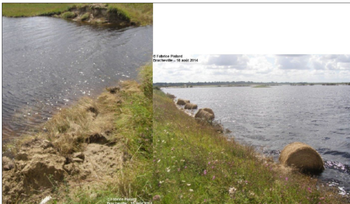
Figure 21: Photos de la brèche (gauche) et du polder (droite) durant la visite de terrain le 18 août 2014, cinq jours après la grande marée. Niveau de crête de l'ordre de 4,5 m IGN
