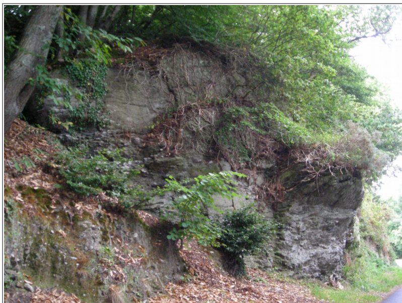
figure 89 : Vue du talus amont du chemin de Brécourt à l'aval du pont de la Bonde.
