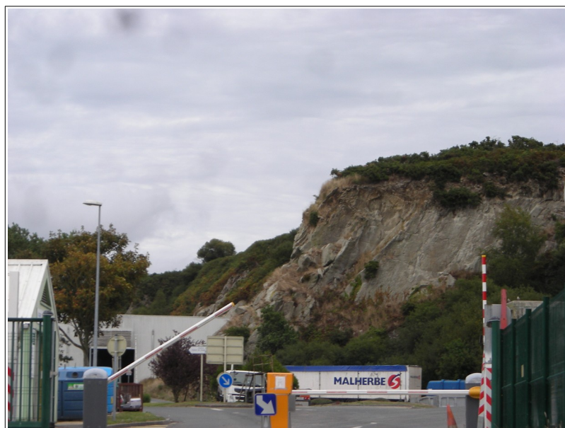
figure 84 : Déchetterie de Tourlaville installée sur le carreau d'une ancienne carrière.
