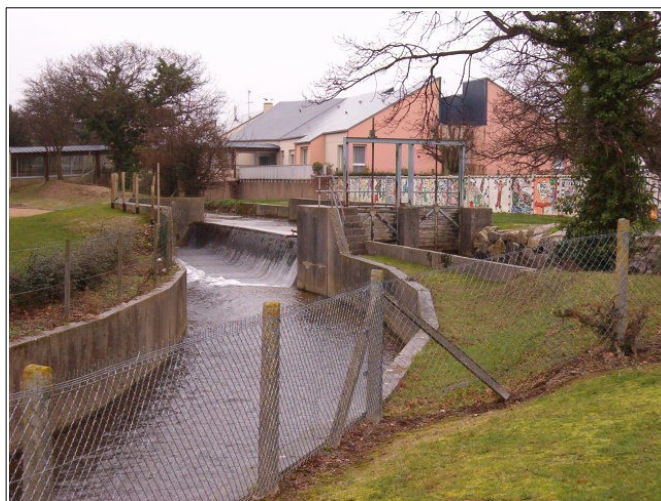
Photo 24: ouvrage de dérivation du Trottebec dans le quartier de la mairie de Tournaville.
