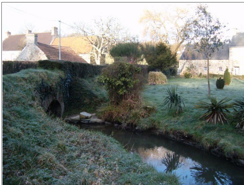
Photo 15: pont de la RD222 au hameau de la Planche au Maître.
