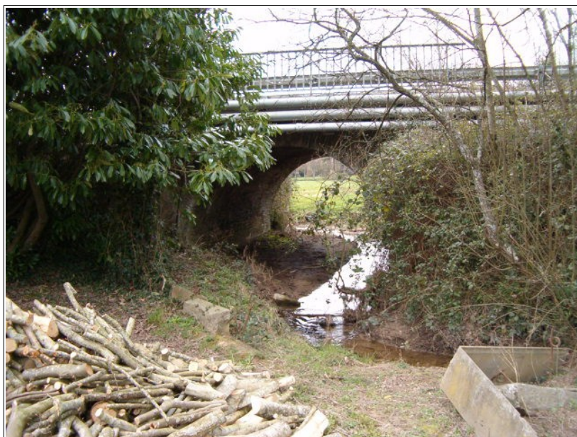
Photo 18: ouvrage de la RD650 au niveau du hameau de Pont.
