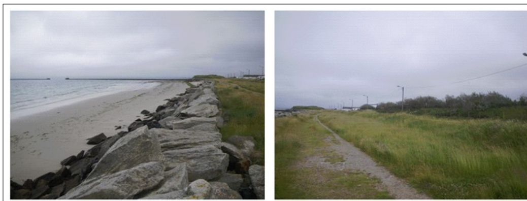
Photo 4 : plage séparée de la dune par des enrochements au point 28 à Turlaville
