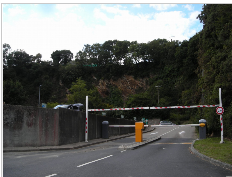
figure 92 : Déchetterie de Querqueville, on distingue à droite de la photo et en arrière plan l'ancien front de taille de la carrière d'où peuvent se détacher des blocs.
