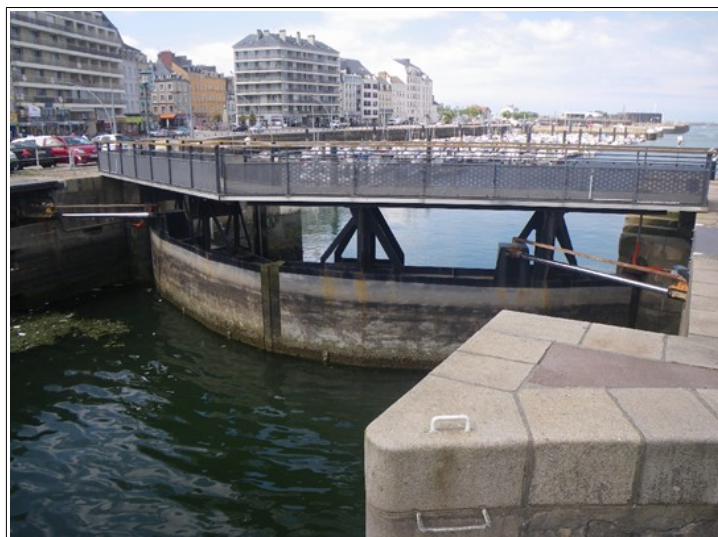
Photo 13 : pont écluse du bassin du Commerce.
