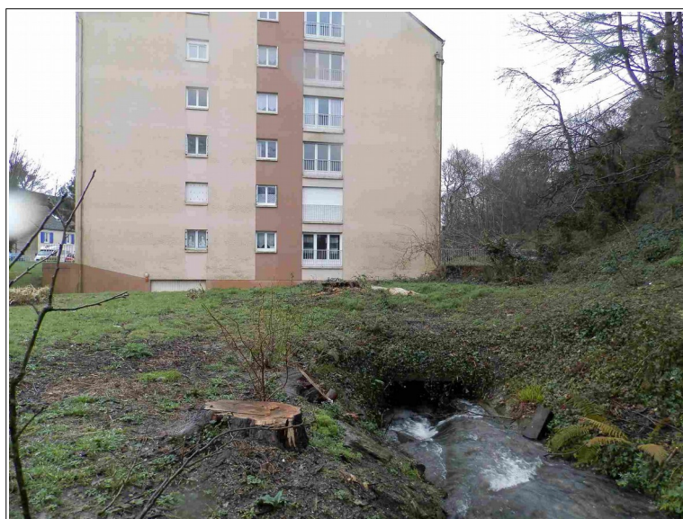
Photo 27: couverture du ruisseau du Fay au niveau du Val l'Abbé.
