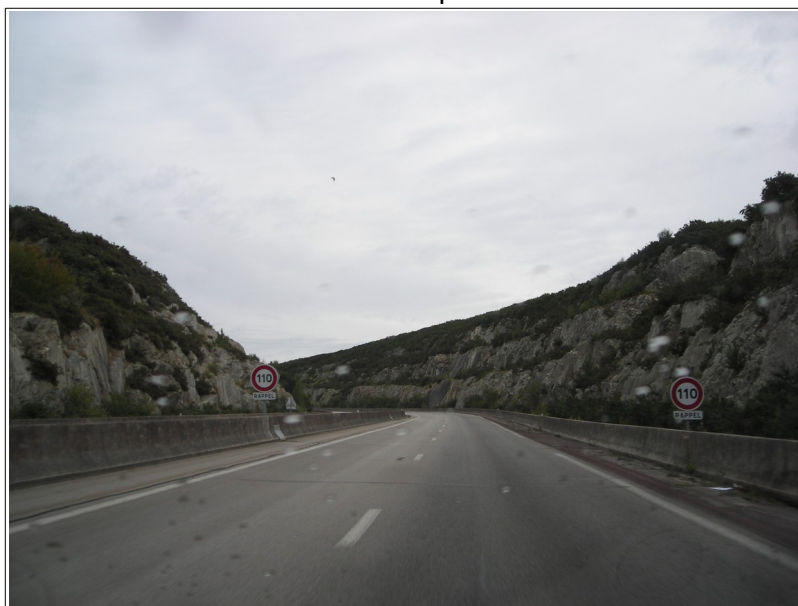
figure 85 : Tranchée de la RB 13 à Tourlaville
