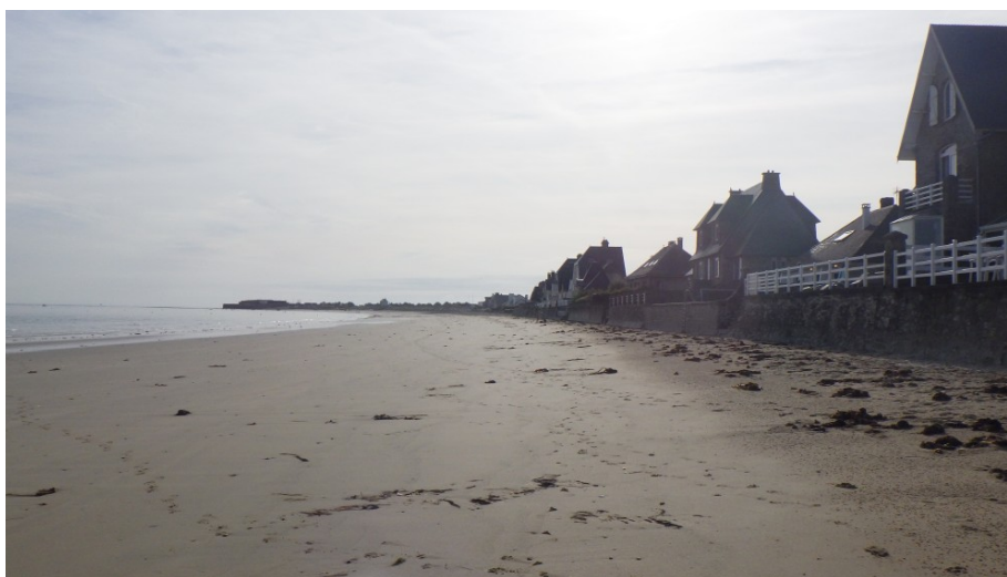
Figure 52: Protection du trait de côte par perrés et murets au droit du Bourg d'Urville
