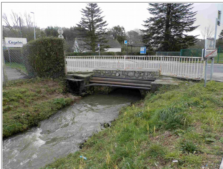
Photo 30: franchissement de la rue des Claires par le Lucas.
