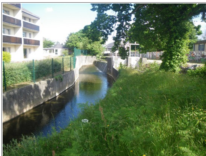
Photo 9 : déversoir et vannes barrage du Trottebec à la limite amont de sa dérivation
