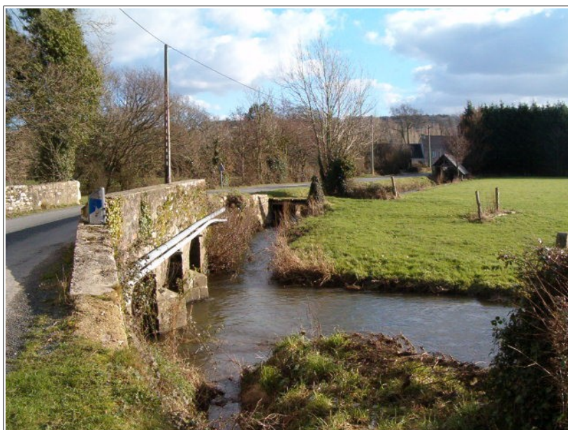
Photo 17: pont de la RD122 au niveau de Sideville.
