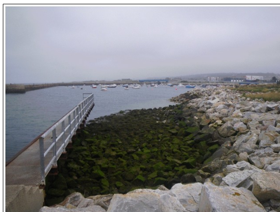
Photo 8 : port des Flamands avec brise-lames et quais (protection par des enrochements)
