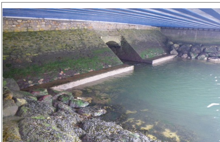
Photo 10 : exutoire du Trottebec dérivé dans le port des Flamands
