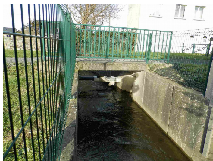
Photo 33: Chenal du ruisseau de la Biale à l'aval de la RD45. On notera la canalisation en travers.
