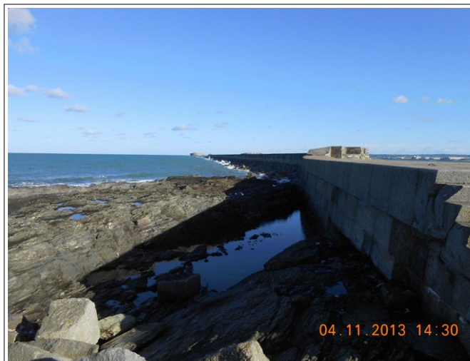
Photo 7 : digue de Querqueville ancrée sur un rocher (IMDC, 2013)
