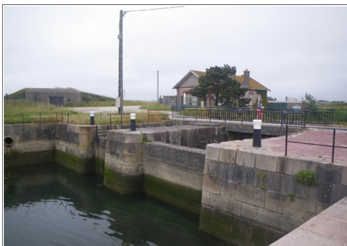
Photo 11 : extrémité Est du port des Flamands, où se trouve la vanne avec clapet anti-retour vers les marais.
