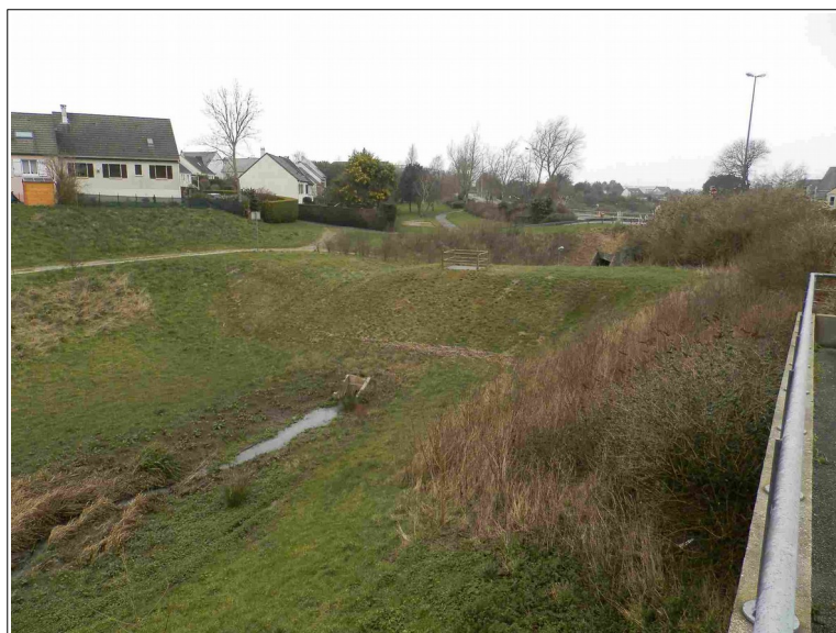
Photo 25: bassin de rétention de l'avenue René Schmitt.
