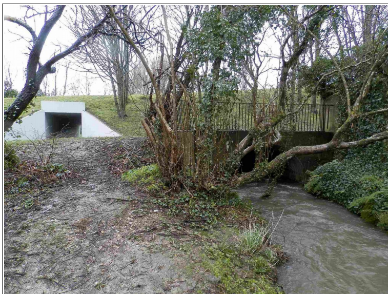
Photo 28: franchissement de la rue Jacques Prévert par le ruisseau de Vaublet. En arrière plan la piste cyclable franchissant également la route.
