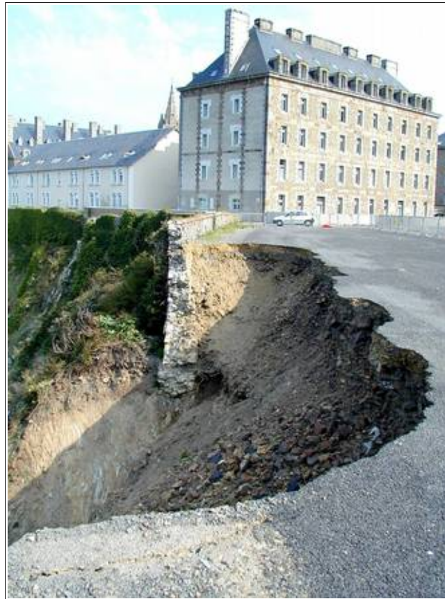
14 : commune de GRANVILLE , éboulement de juin 2001 au niveau de l'ancienne PLACE D'ARME réaménagée en parking. Une bande de terrain large d'environ 2 mètres s'est éboulée sur la plage, entraînant avec elle une partie de la bordure de la place et son mur de soutènement.
