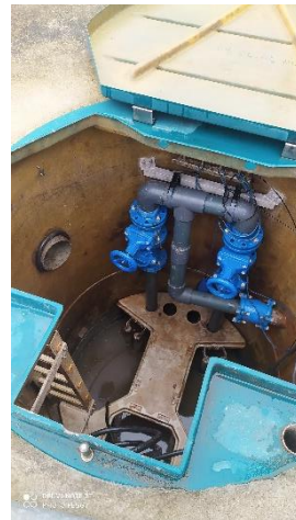
Figure 1 : Photo du site ou les drains d'épandage sont localisés (pas de plan existant)
