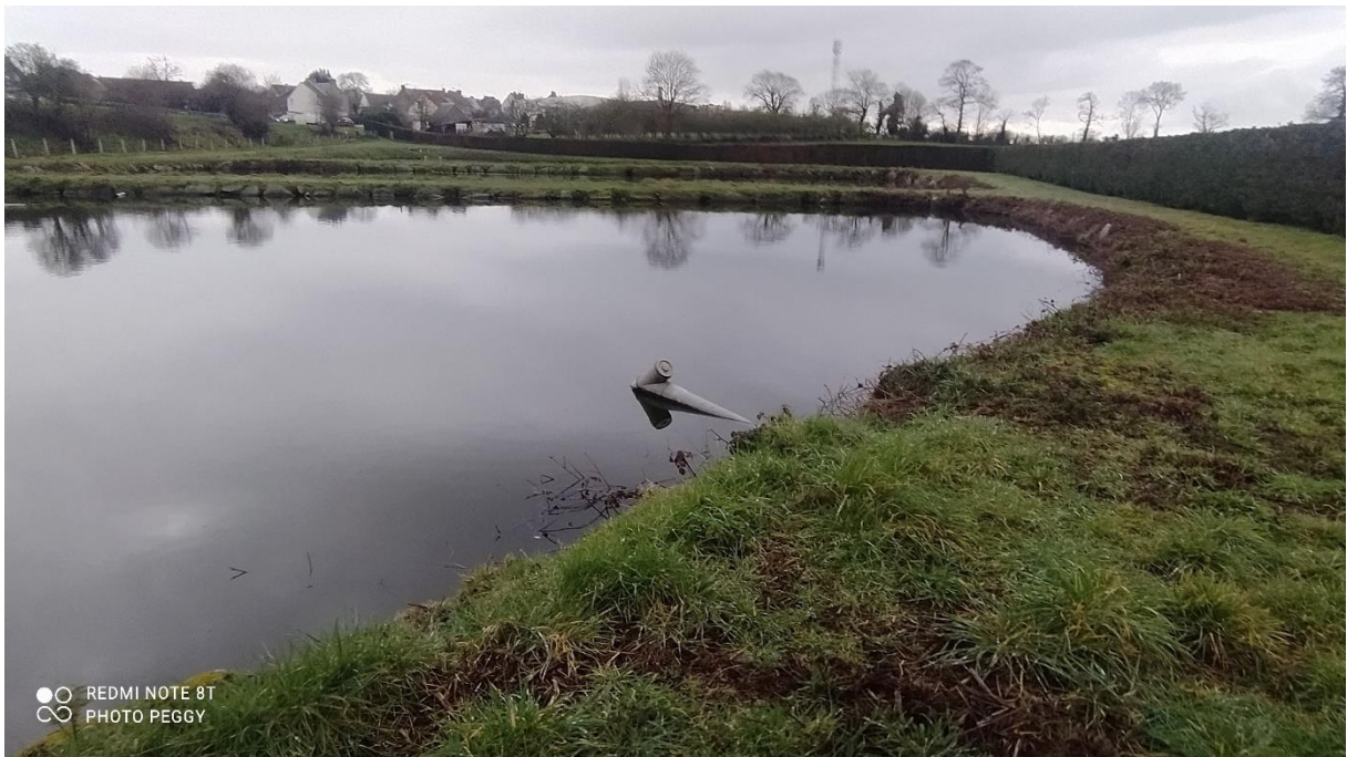
Photos de la station d'épuration
