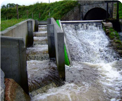
Passé à poissons du Bieu
