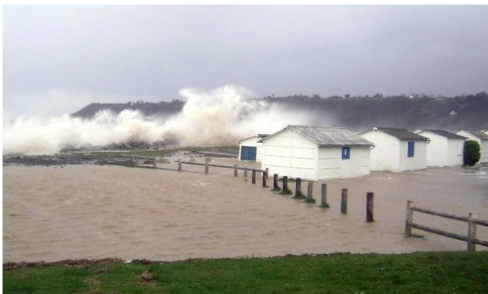
Figure 14 : Franchissement par paquet de mer observé au niveau de cabines de Saint-Jean-le-Thomas lors de la tempête de mars 2010 (Source : DDTM 50)
