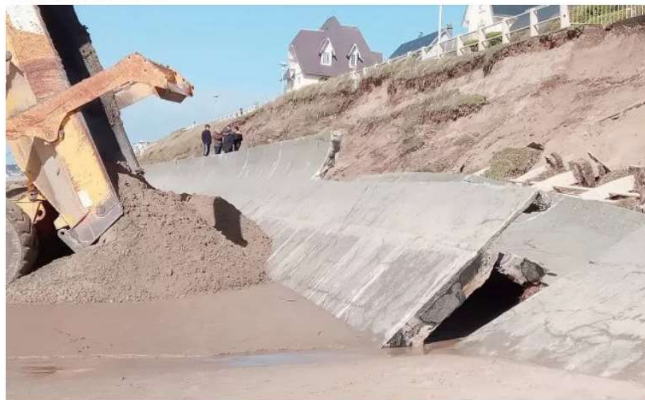
Dès l'après-midi les engins de chantier ont commencer à combler et empierrer à l'endroit où la digue a cédé à hauteur de l'avenue de la Martin
