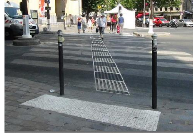
Expérimentation des dispositifs destinés à guider les piétons lors de la traversée - Paris
