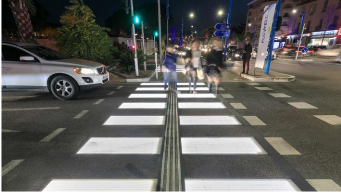
Expérimentations de Flowell, de signalisation lumineuse dynamique - groupe Colas
