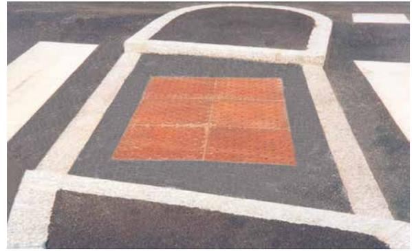
BEV implantée sur îlot-refuge avec traversée en 2 temps, largeur comprise entre 1,50 et 1,80 m
