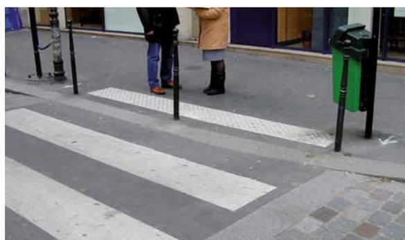
BEV implantée au droit d'une traversée avec chaussée surélevée.
