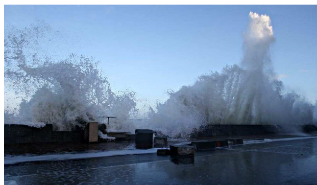
Illustration 40 : Dégâts sur la digue de Saint-Malo suite à la tempête des 2 et 3 février 2014 (crédit photo : SeT de Saint-Malo)
