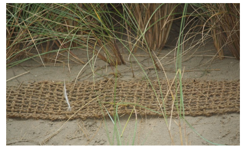
Filet anti-érosion en fibres de coco et plantation d'oyats - © Cerema
