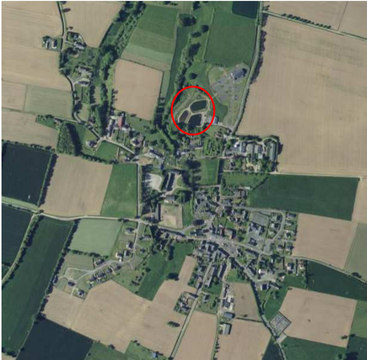
Figure 13 : Carte de localisation de la station d'épuration sur la commune de Saint Laurent de Terregatte
