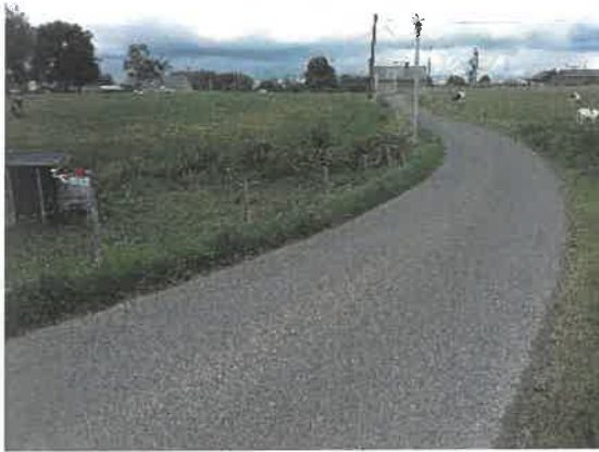
Photos 3 – route communale au-dessus de l’ouvrage hydraulique
