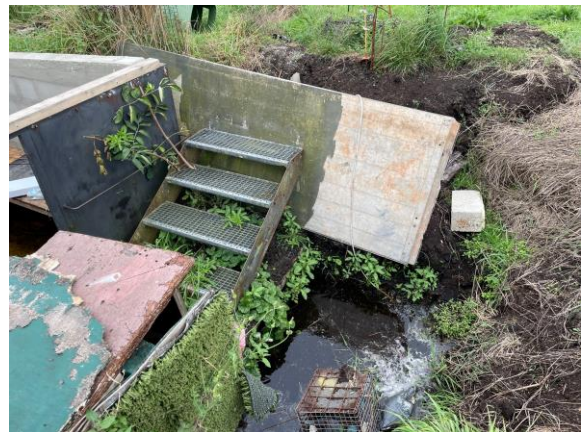
Restes maçonnés de gabion 2/3
