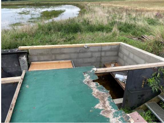
Restes maçonnés de gabion 3/3
