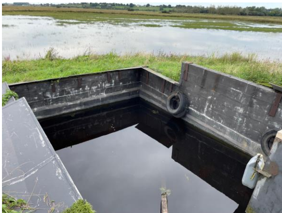
Restes maçonnés de gabion 1/3
