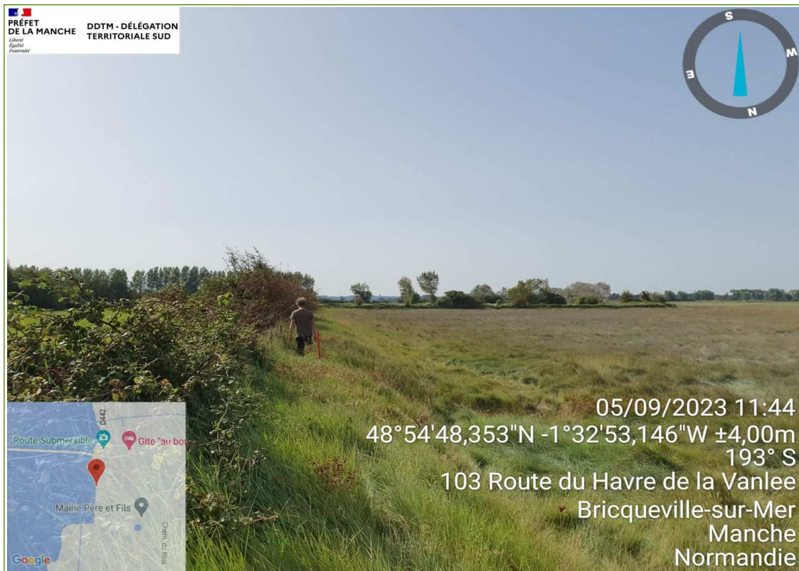
30 – Cheminement en haut de remblai
