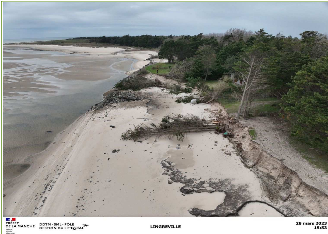
8 – Erosion secteur nord du havre
