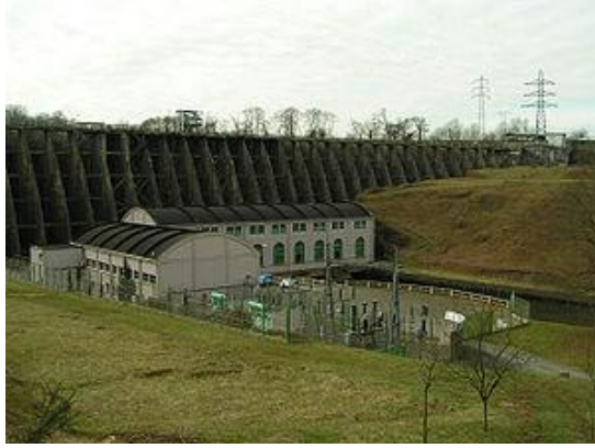
Barrage de Vezins (Crédit Photo: WikiManche)
