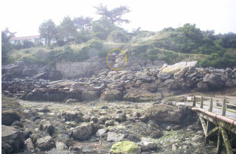
Figure 27 : Écoulements observés par la DDTM50 lors d'une visite de terrain Face à l'embarcadère en bois
