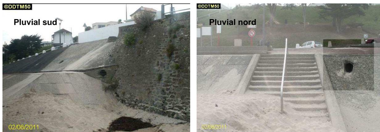
**Figure 54** : Vue sur les deux émissaires pluviaux débouchant sur la plage du Lude à Donville (Clichés DDTM50)
