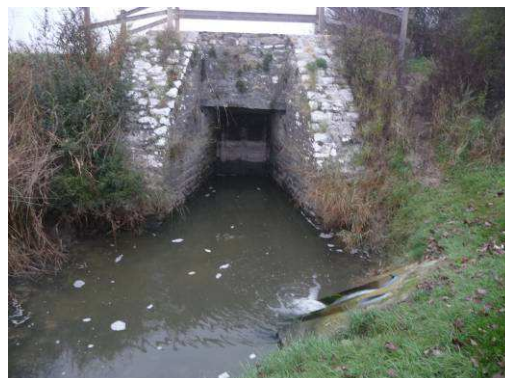
Figure 30 : Vue sur la porte à flot du Canal du Passevin (24/11/2011)
