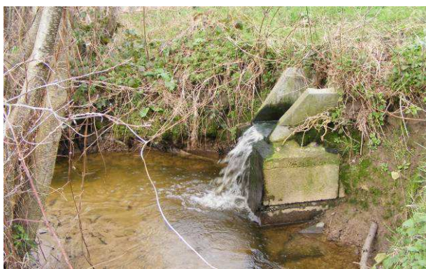
Figure 65 : Vue sur le rejet de la station de Bricqueville-sur-Mer (DT50-ARS BN)
