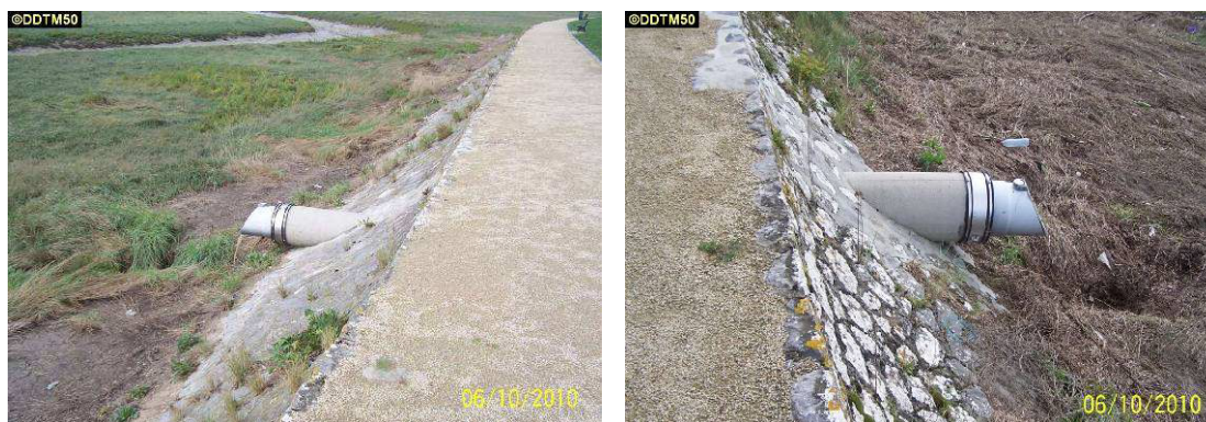
Figure 38 : Emissaires pluviaux débouchant dans le havre de Regnéville (Clichés de la DDTM50)
