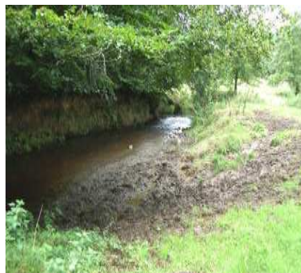
Figure 74 : Illustration du piétinement des berges et de l'accès libre au cours d'eau sur le bassin de la Souilles (ALIZE, 2005)
