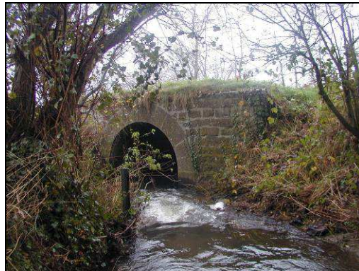
Figure 35 : Vue sur le point de suivi des rejets du ruisseau des Hardes
