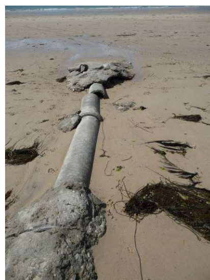
Figure 34 : Emissaire côtier sur la plage d'Armanville (n°15)
