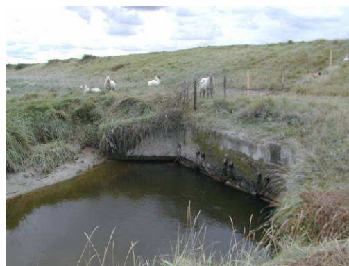
Figure 29 : Vue sur l’exutoire du Dun
