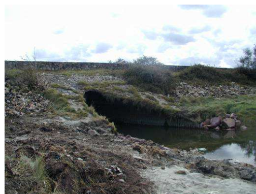
Figure 23 : Vue sur l'exutoire de l'Ay
