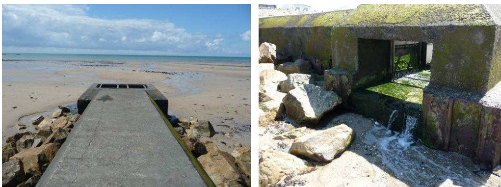
Figure 35 : Vue sur l'exutoire du Dy
