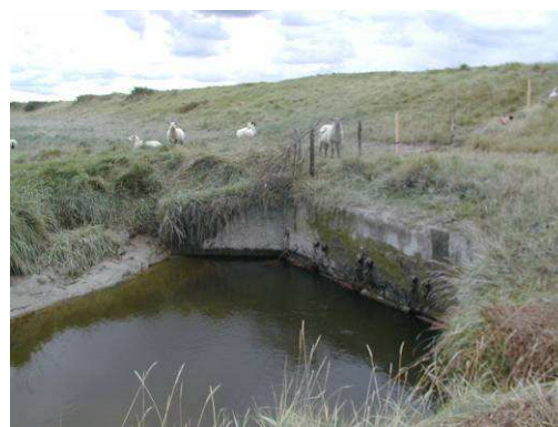
Figure 27 : Vue sur l’exutoire du Dun
