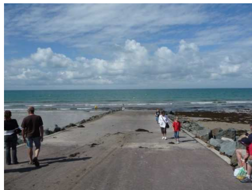
Figure 2 : Vue sur la cale de Saint-Germain-sur-Ay nord (face à la RD 306)
