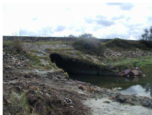
Figure 21 : Vue sur l'exutoire de l'Ay
