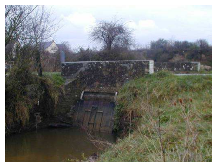
Figure 26 : Vue sur l'exutoire de la Brosse
