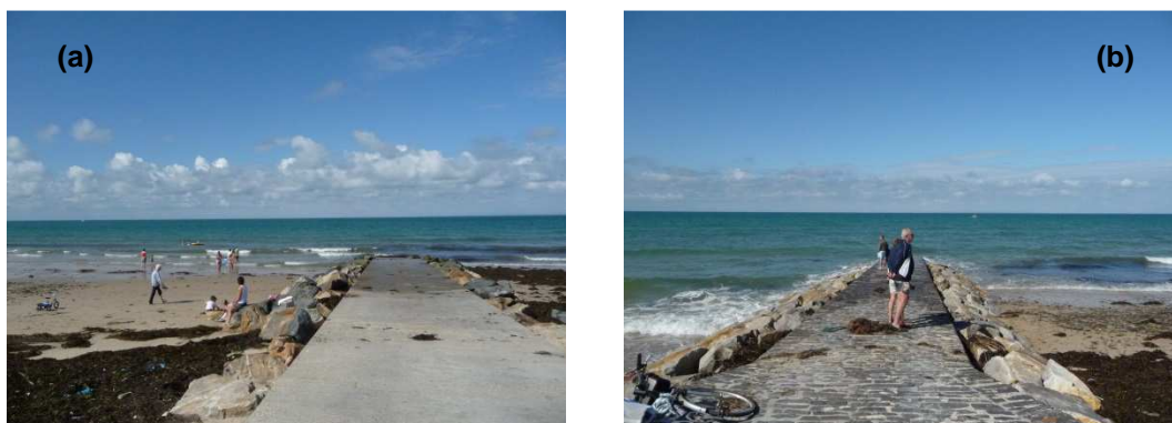
Figure 2 : Vue sur (a) la cale de Bretteville-sur-Ay et (b) de Glatigny
