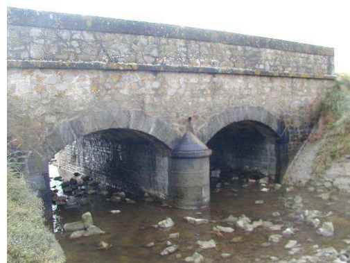
Figure 24 : Vue sur l'exutoire de l'Ouve
