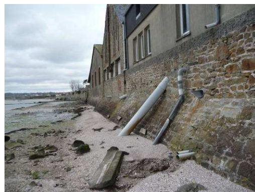
Figure 48 : Quelques exutoires du bassin n°5
