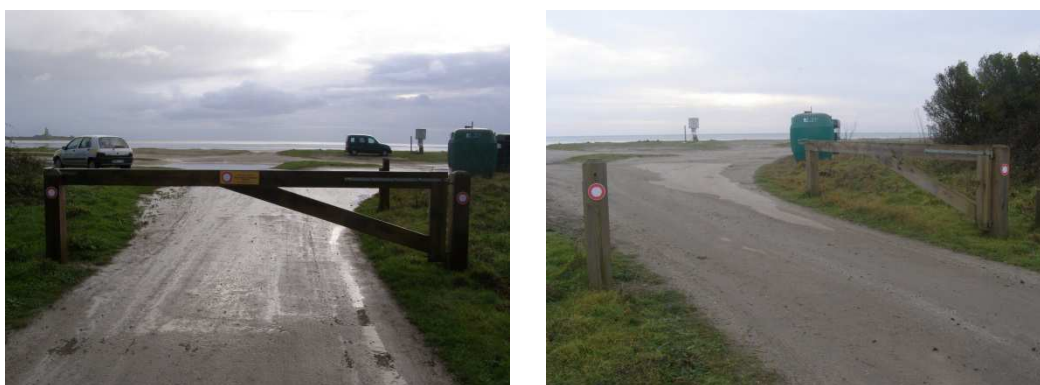
Figure 60 : Cliché de la barrière installée à Morsalines - la Redoute (DDTM50)
