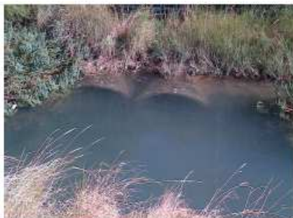
Photo 25 - Fossé longeant le sentier Vauban - Buses centre Le 17 septembre - Coeff 104 - Pleine mer
