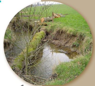
▲ Encombre obstruant totalement le lit, à enlever.
