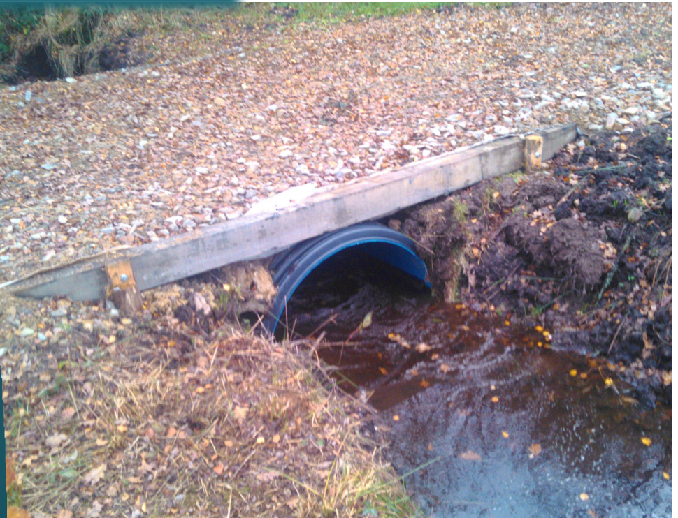
La mise en place d'une passerelle et de clôtures ou d'une demi-buse, permet aux animaux de passer librement d'une berge à l'autre sans pénétrer physiquement dans le lit de la rivière.
