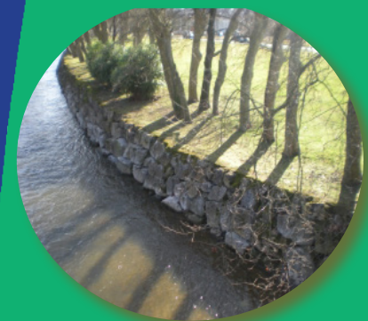
▲ Enrochements de berge
