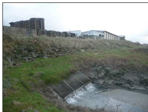
Figure 37 : Vue sur le rejet de la ZAC de Blainville
