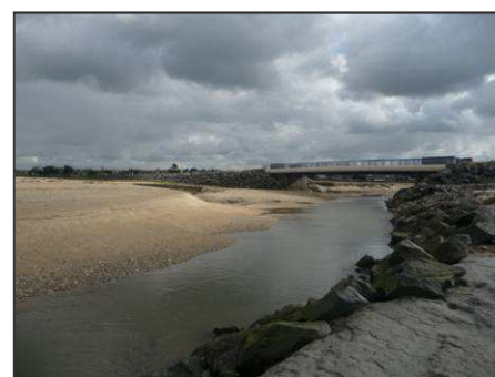
Figure 34 : Vue sur l'exutoire de l'écoulement sud du havre de Blainville
