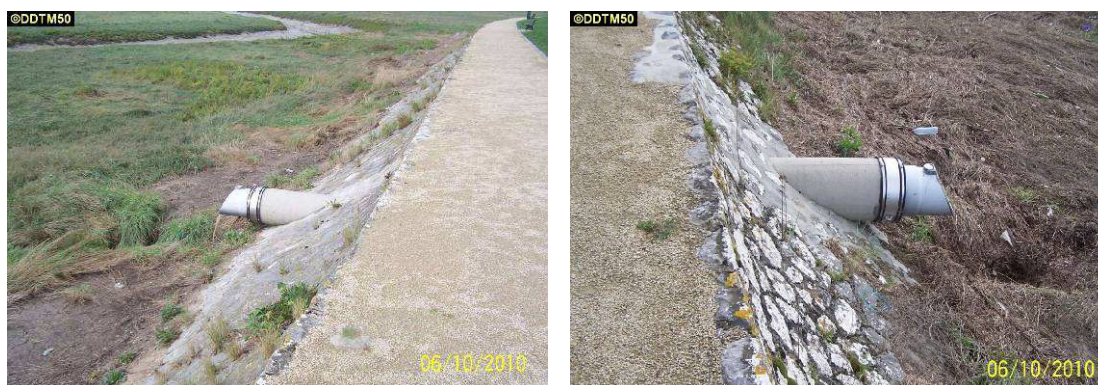
Figure 46 : Émissaires pluviaux débouchant dans le havre de Regnéville (Clichés de la DDTM50)
