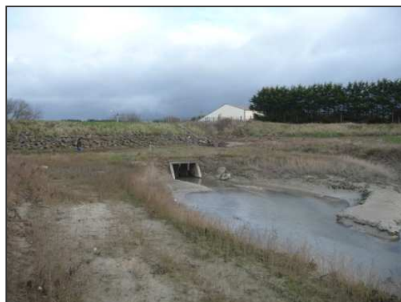
Figure 36 : Vue sur le rejet de la CABANOR
