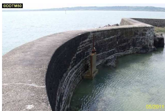
Figure 28 : Émissaires pluviaux du littoral réveillais (Clichés de la DDTM 50 et DT50 de l’ARS BN)
