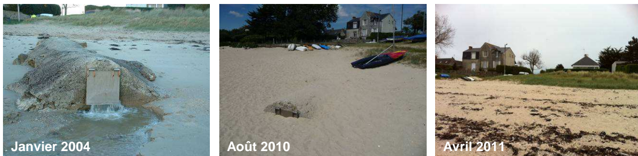
Figure 26 : Ensablement de l'émissaire pluvial de Jonville (photos DT50-ARS BN et LDA 50)
