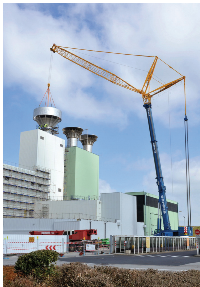
Pose de la cheminée de l'alvéole 30
